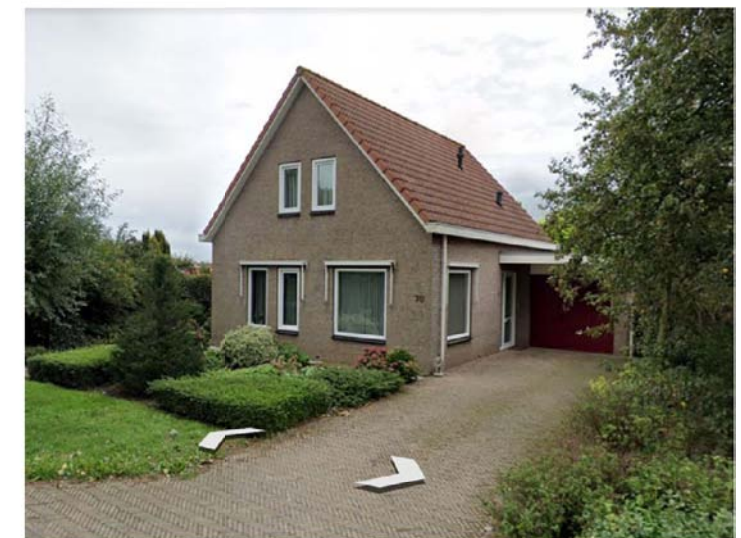
2. bestaande woning Hoogeweg 70
