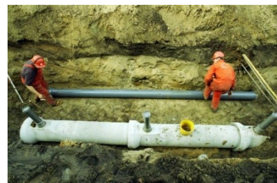
Figuur 2 Gescheiden rioolstelsel (RIONED)
