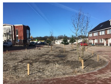
Figuur 3 Wadi in aanleg (Varne Buiten)
